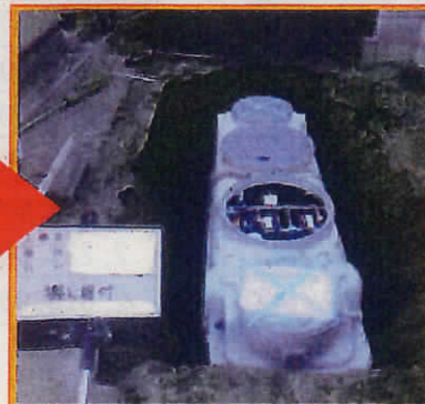
合併浄化槽設置
