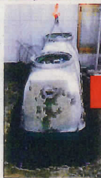
単独浄化槽撤去
